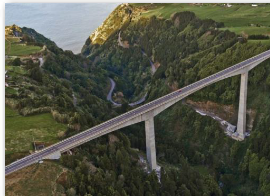
Ponte Despe-te que Suas - Município de Nordeste Cortesia FERROVIAL
